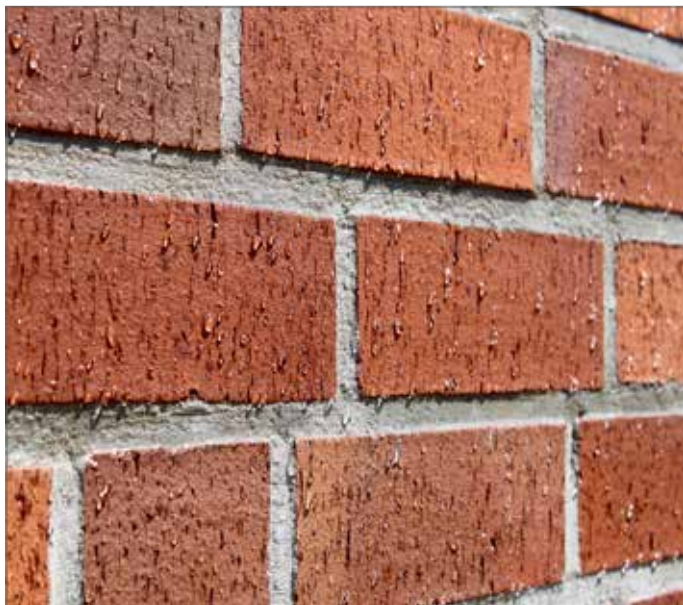
Abb.2, Imprägnierte Fassade. Wasser perlt ab und der Baustoff ist trocken.
